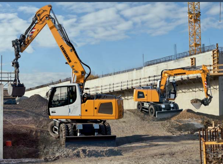
Construction/การก่อสร้าง
