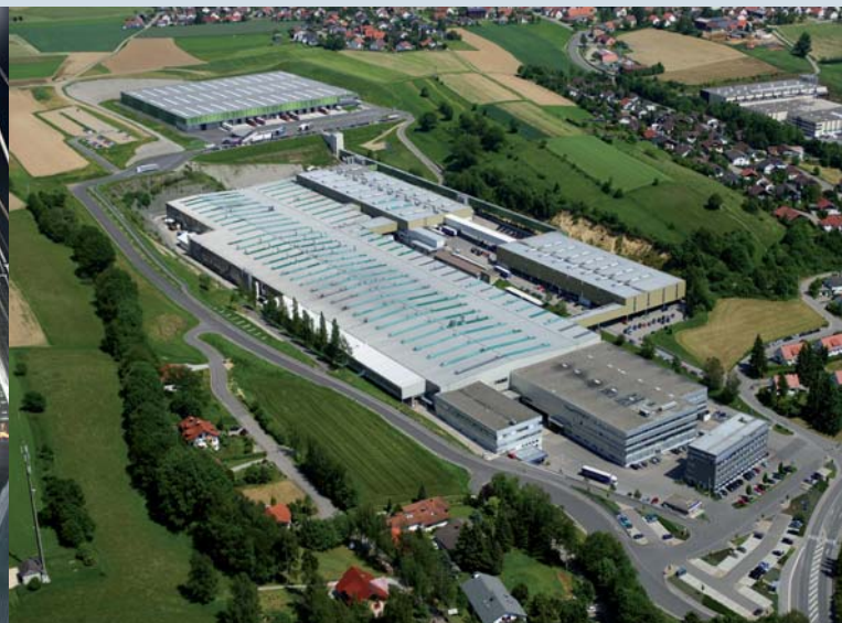
Liebherr Appliances facility in Ochsenhausen, Germany โรงงานผลิตเครื่องใช้ไฟฟ้าของ Liebherr ในเมือง Ochsenhausen ประเทศเยอรมนี
